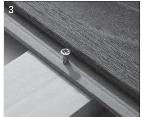
Schneiden Sie die letzten Paneele jeder Reihe so zu, dass mindestens 10–14 Millimeter Wandabstand berücksichtigt sind. Zum Einpassen der letzten Reihe verwenden Sie ein Paneele Reststück, um die verbleibende Paneelebreite anzuzeichnen (mindestens 10–14 Millimeter Wandabstand berücksichtigen). Das Paneele befestigen Sie im unmittelbaren Wandbereich mit Nägeln oder Schrauben wie die Paneele der ersten Reihe.
